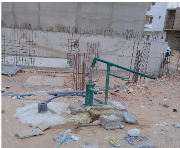
Photo 5- Pompe manuelle dans un chantier de construction, Hann Maristes 1
