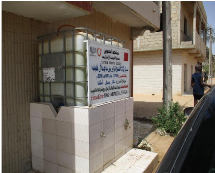
Photo 10- Pompe électrique équipée de robinets, Cité COMICO 4
