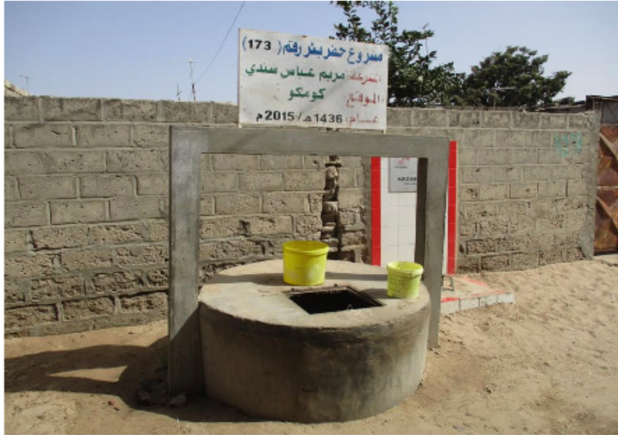
Photo 8- Puits protégé, Alé Baye Niakh, Yeumbeul Sud
